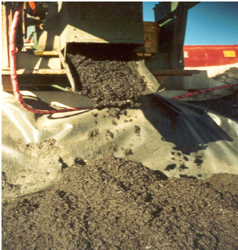
Fig 3.11.- Producción de Mezcla con emulsión
